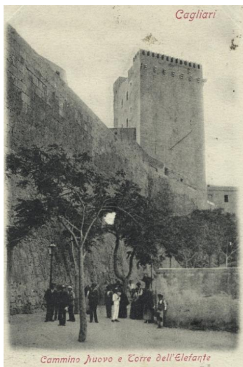
Fig. 16 - La torre dell'Elefante appare ancora tamponata con le oblitterazioni del muro aragonese, demolito nei restauri del 1906 ( http://www.sardegna.digitalibrary.it/index.php?xsl=2436&s=17&v=9&c=4461&id=34045 )
