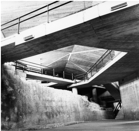
Fig. 8,9 - Cittadella dei musei, interni. (Archivio dell'Università di Cagliari)
