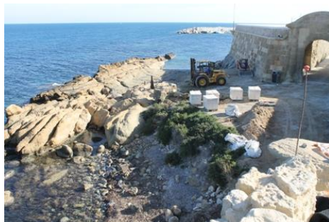
Fig. 8 - Obras en el baluarte del Príncipe, junto a la puerta de Tierra y restos del puerto antiguo. (Santiago Varela 2015)
