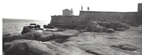
Fig. 3 - La muralla noroeste antes de la restauración. (Santiago Varela 1979)
