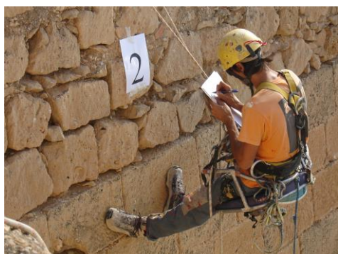
Fig. 13- Operario croquizando una lesión en el frente murario (foto autor, 2009)
