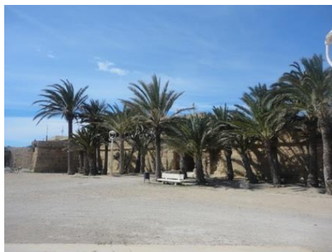
Fig. 1 - Aspecto actual del frente de levante. (Santiago Varela 2014)
