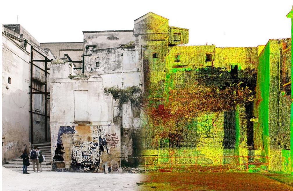
Fig.8 visualizzazione di una fotografia congiunta con la nuvola di punti ottenuta mediante laser scanner statico
