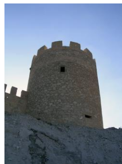
Figs. 4 y 5- Vista frontal de la Torre Grossa con la puerta de acceso en sillería y vista oeste con la boca de la cañonera en la planta baja (autor: Juan Antonio Mira Rico).
