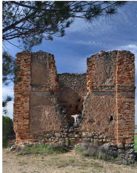
Fig. 4- Torre de Valverde (Bértolo, 2017)
