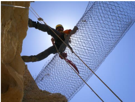
Fig. 9- Operario portando un rollo de malla de triple torsión (foto autor, 2008)
