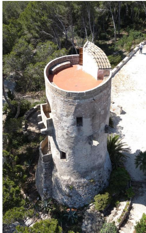
Fig. 4- Torre de Cap Prim o del Portitxol, Xàbia, mayo de 2016.
