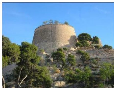
Fig. 2 Estado actual del baluarte
