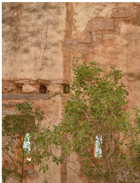
Fig. 7- Evidencias de huellas y contrahuellas de escalera en la torre 19 (Bértolo, 2017)
