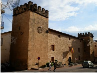
Fig. 12- Vista del Palau de Onil (autor: J. A. Mira Rico).
