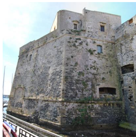
Fig. 4 – Torrione poligonale, lato NE.
