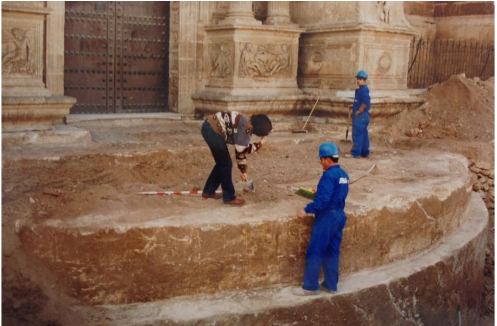
Fig. 2- Vista de los cimientos de la torre desde la portada Norte (Carmen Mellado, 1999)
