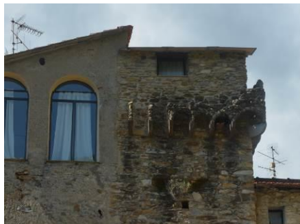
Fig. 6 – Particolare dei beccatelli della torre di Isolalunga di Dolcedo.
