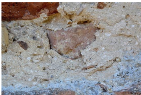
Fig. 4 - Aspetto macroscopico di una malta del XVI secolo (bastione di Porta Laterina).
