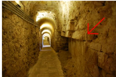
Fig. 7 – Corridoio di accesso al torrione: a destra, una delle bocche di fuoco.
