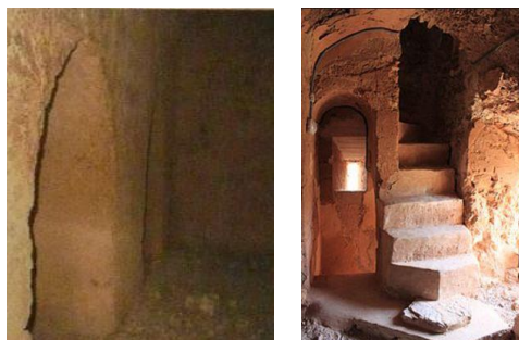
Fig. (- Interior de la torre vigía almohade. Fotografías de Francisco Cervera Arias
