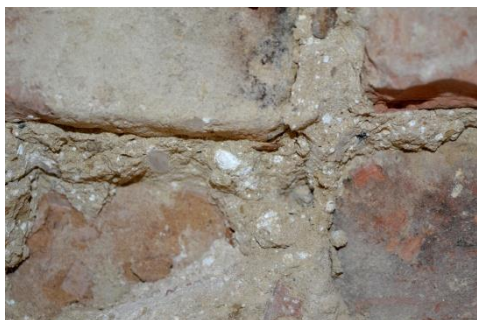
Fig. 3 - Aspetto macroscopico di una malta del XV secolo (tratto di mura presso la fonte di Follonica).
