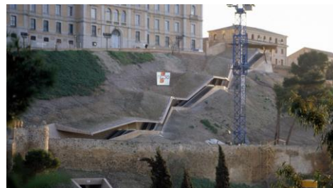
Fig 3. La Granja Escalators. (Jose Antonio Martínez Lapeña y Elias Torres Architects)
