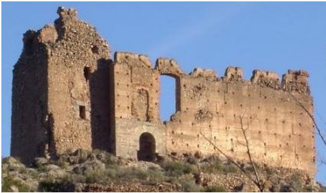
Fig. 5- Vista general del castillo de Beselga antes de la intervención donde se aprecia el acceso original a la torre, a media altura recercado de piedra. También el acceso al castillo palacio con arco de medio punto de estrechas dovelas. Sobre el arco las dos ventanas que fueron aljimezadas situadas en la primera planta o planta noble. Estas ventanas darían luz a la sala noble como era tradicional en los palacios góticos. Se distinguen claramente los huecos dejados por las agujas del tapial en los muros del castillo palacio. Colección particular del autor
