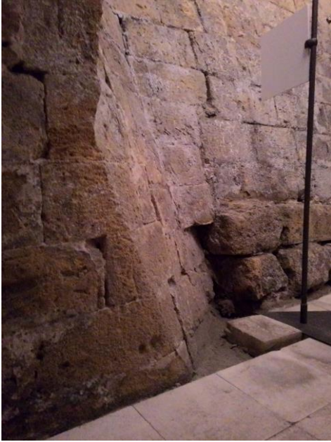
Fig. 12 – Muratura che connette la porzione muraria E della scarpata con il corridoio (Quarta 2016)
