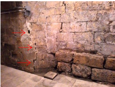
Fig. 13 – Lesione lungo le connessione tra i blocchi (Quarta 2016)
