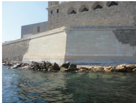
Fig. 6 y 7 - Aspecto de del baluarte Grande de la Concepción, antes y tras la restauración. (Santiago Varela 2013 y 2015)
