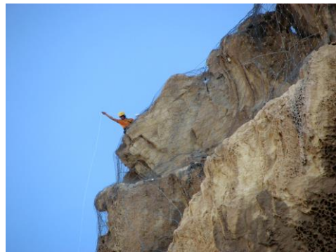
Fig. 7- Operario sobre la “nariz” del perfil del talud “Cara del Moro” (foto autor, 2008)
